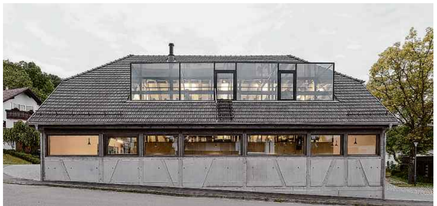
Gelungene Revitalisierung eines historischen Bauwerks am Beispiel der Alten Kelter in Schorndorf-Miedelsbach. Bestandserhaltung mit hoher Wiedererkennung, vielen zukunftsweisenden Details und konsequent moderner Ausrichtung. Architekten: Sigrid Hintersteiner Architects.
