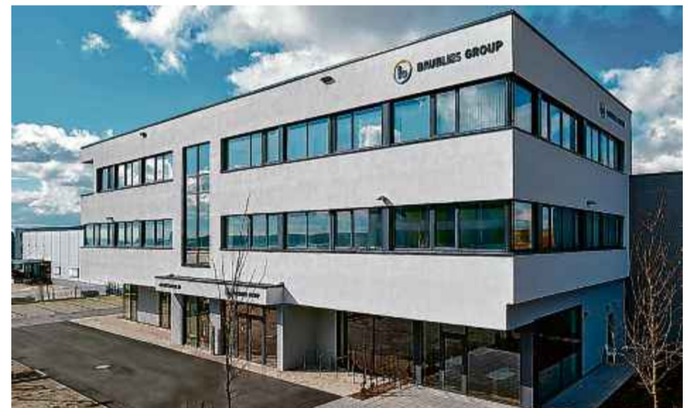
Die Firmenzentrale der Baublies Group im Renninger Gewerbegebiet.
