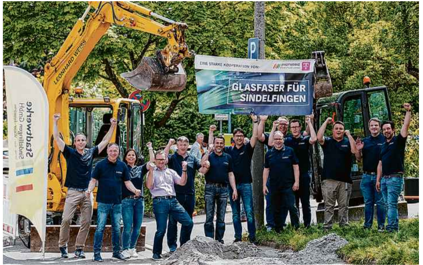
Das Team der Stadtwerke Sindelfingen freut sich über den Spatenstich zum Glasfaserausbau in Maichingen.
