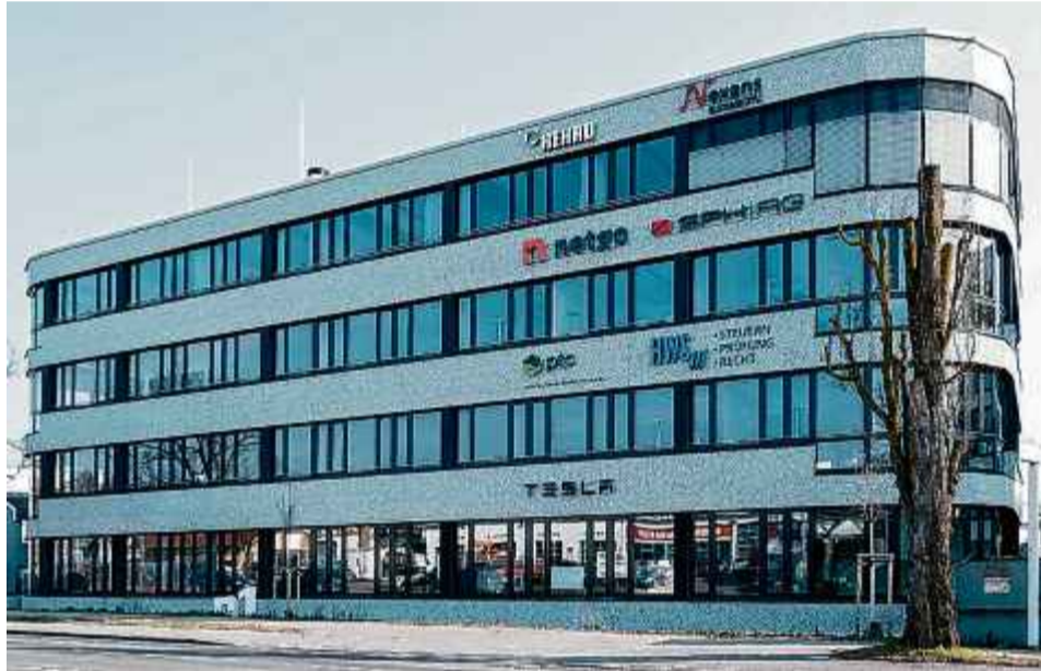
Der HWS-Standort in der Sindelfinger Neckarstraße 40.
