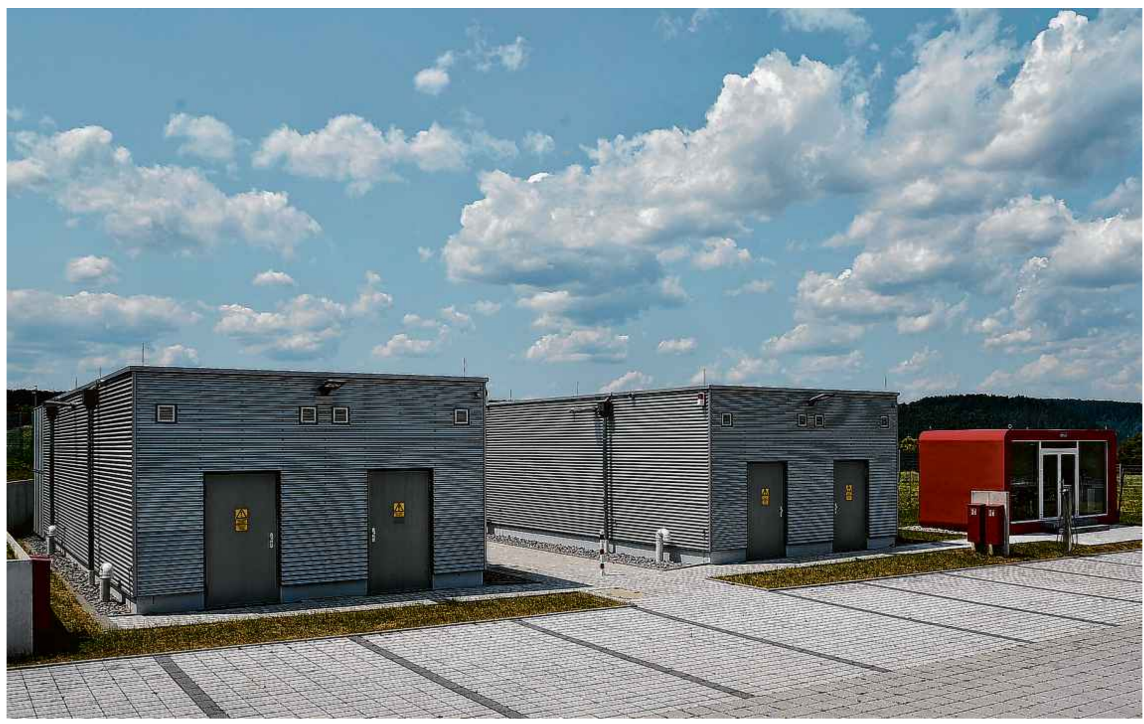
Die S-IT hat ihr Rechenzentrum für Besprechungen und mobiles Arbeiten erweitert.
