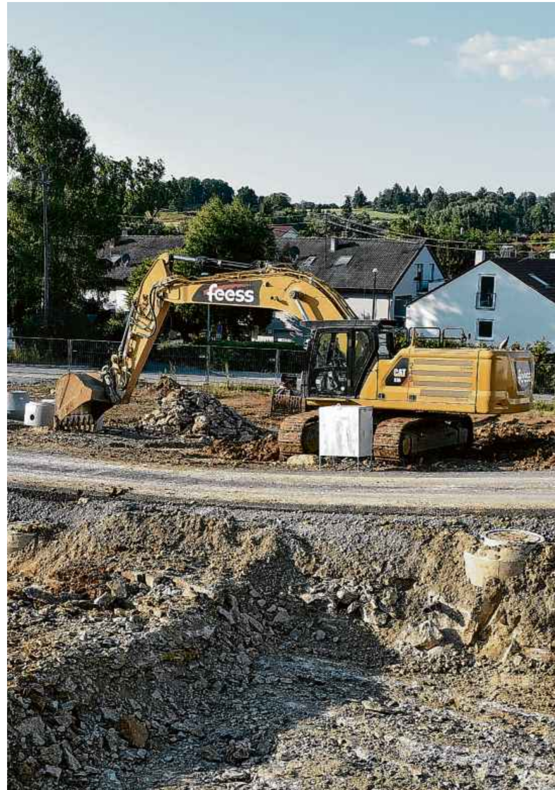
Die BBG hat an der Ihinger Straße in Magstadt mit dem Bau begonnen.
