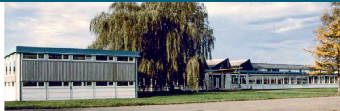
Neues Firmengebäude auf der Böblinger Hulb
